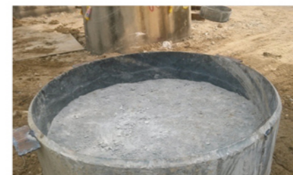
08 1차콘크리트 타설 선단철근망 + 내부Con'c 채움
