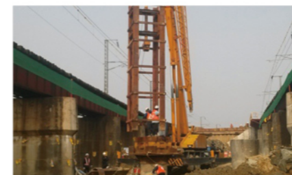
07 동재하시험 Crane + 재하장비 1식
