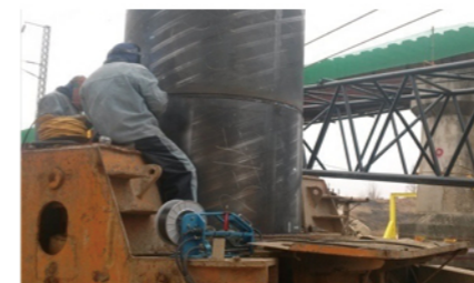
04 강관용접 (crane+용접공) 2~4단계 반복작업
