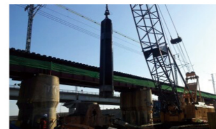
05 말뚝 선단 암파쇄작업 Crane + Chisel
