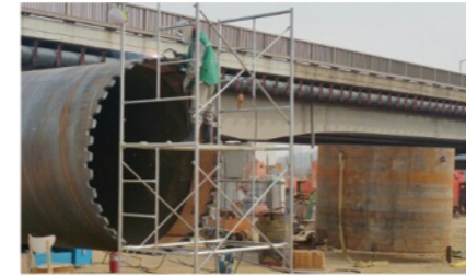
01 준비 작업 선단보강 작업
