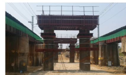
11 지상부 강관설치 및 코핑부 거푸집 설치
