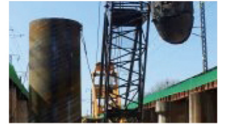
03 강관내부 토사굴착 Crane + Hammer Grab
