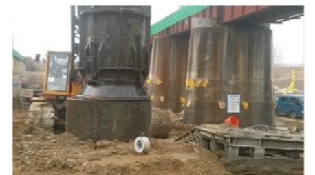
06 선단부 슬라임 제거 Crane + 슬라임제거기
