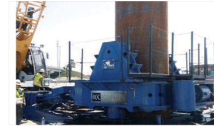
02 강관 압입 Oscillator + Crane
